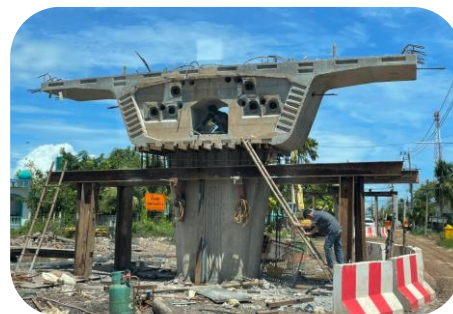
งานคอนกรีต Pier Segment P2
