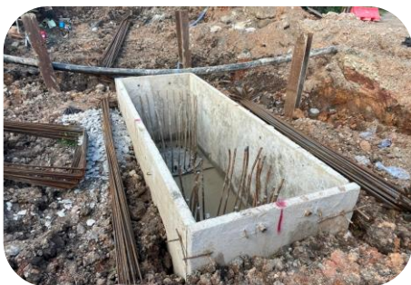
งานโครงสร้างฐานราก P7
