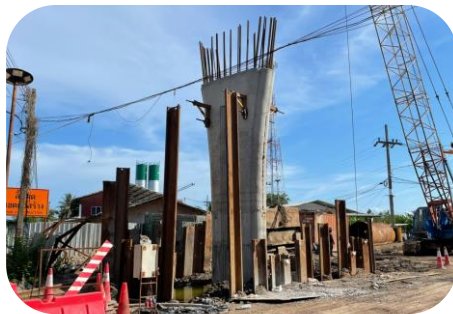
งานโครงสร้างเสาตอม่อ P4
