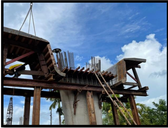
ภาพแสดงงานติดตั้ง Pier Segment (P๓)
