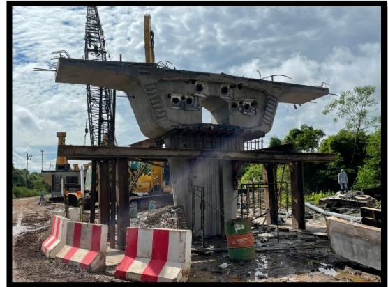
ภาพแสดงงาน Pier Segment (P๒)
