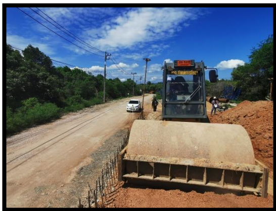
ภาพแสดงงานบดอัดชั้นทรายถมคันทาง ช่วง Transition
