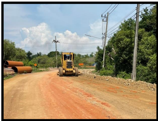
ภาพแสดงงานปรับเกลี่ยและบดอัดชั้นรองพื้นทาง Sta.๐+๐๐๐ ถึง Sta.๐+๔๕๐
