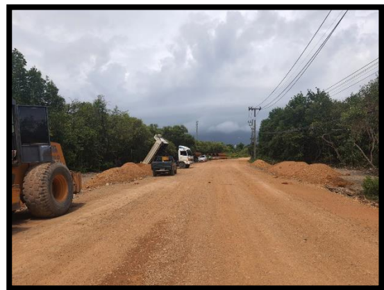
ภาพแสดงงานปรับเกลี่ยและบดอัดชั้นรองพื้นทาง Sta.๐+๐๐๐ ถึง Sta.๐+๔๕๐
