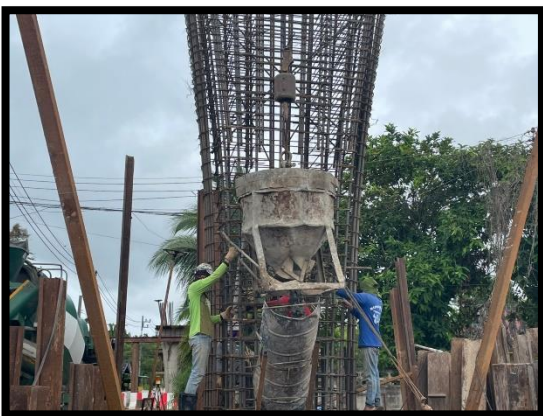
ภาพแสดงงานเทคอนกรีตเสาตอม่อ (P๔) ช่วงที่ ๑
