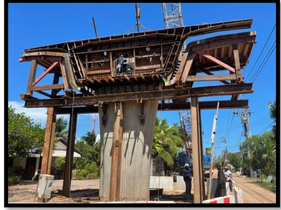
ภาพแสดงงานผูกเหล็ก Pier Segment (P๓)
