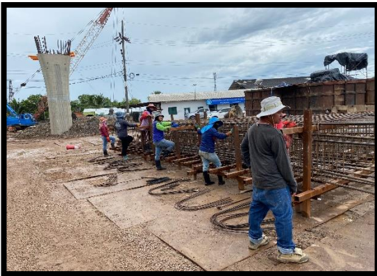
ภาพแสดงงานผูกเหล็กเสาตอม่อ (P๔)
