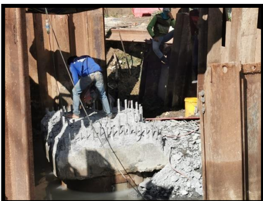
ภาพแสดงงานตัดแต่งหัวเสาเข็มเจาะ (P๔)
