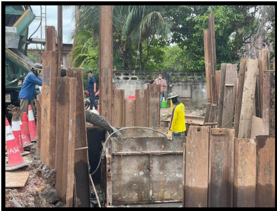
ภาพแสดงงานเทคอนกรีต Pile Cap (P๔) เพื่อทดสอบ Dynamic
