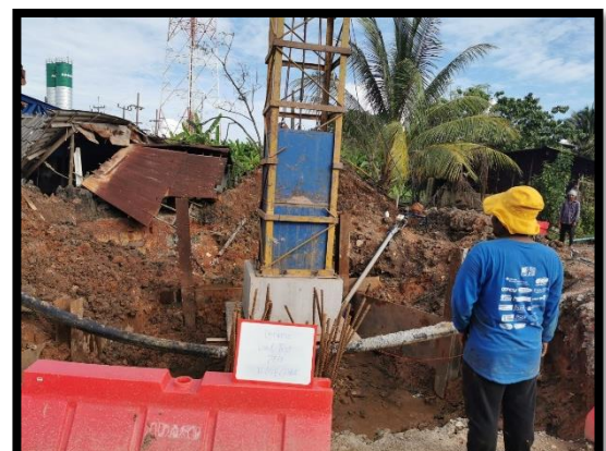
ภาพแสดงงานทดสอบกำลังรับน้ำหนักของเสาเข็มเจาะ ด้วยวิธี Dynamic (P๗)
