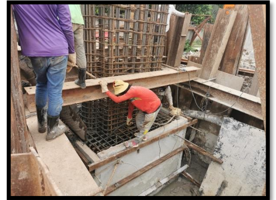
ภาพแสดงงานเทคอนกรีตฐานราก (P๔)
