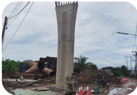
งานโครงสร้างเสาตอม่อ P6
