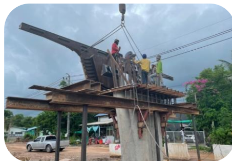
งานติดตั้งอุปกรณ์หล่อ Pier Segment P2
