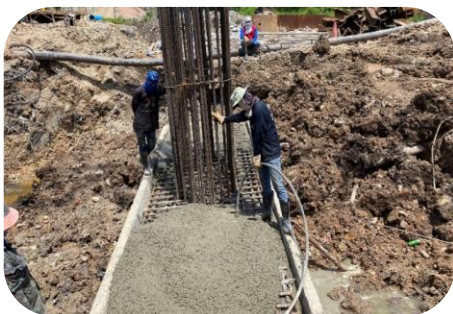
งานโครงสร้างฐานราก P6
