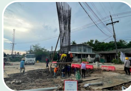
งานโครงสร้างเสาตอม่อสะพาน P5
