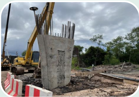
งานโครงสร้างเสาตอม่อสะพาน P2
