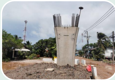
งานโครงสร้างเสาตอม่อสะพาน P3
