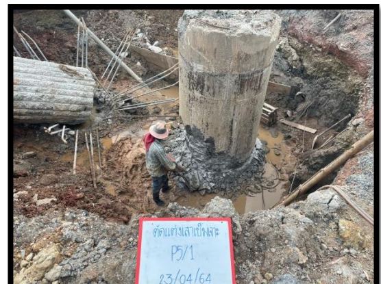
ภาพแสดงงานติดตั้งเสาเข็ม (P๕/๑)
