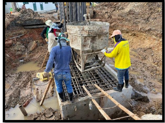
ภาพแสดงงานเทคอนกรีตฐานราก (P๕)
