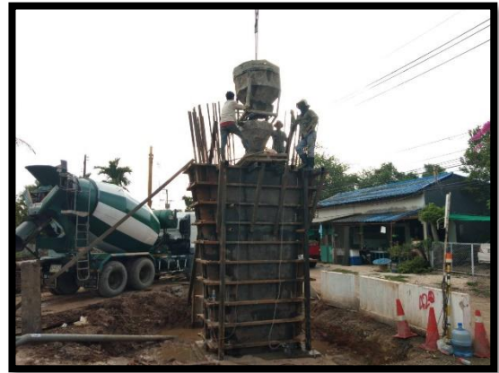
ภาพแสดงงานเทคอนกรีตเสา (P๒)
