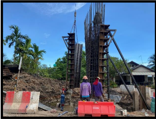
ภาพแสดงงานเข้าแบบเสา (P๓)
