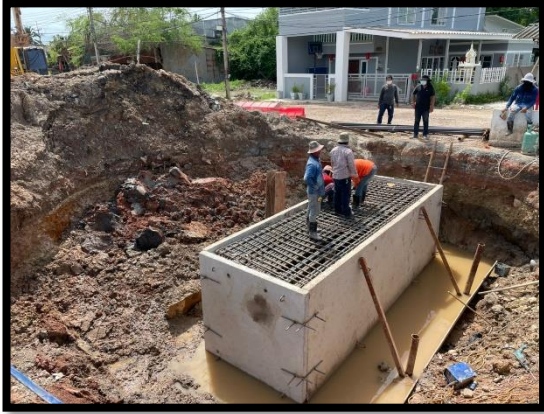
ภาพแสดงงานผูกเหล็กฐานราก (P๕)
