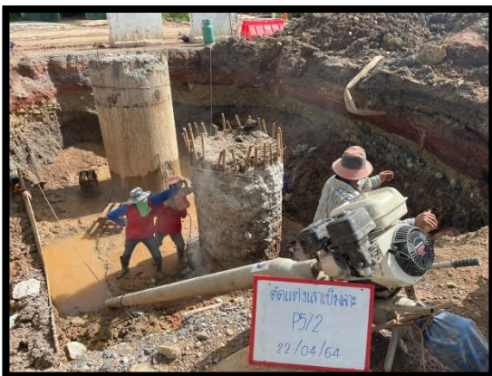
ภาพแสดงงานติดตั้งเสาเข็ม (P๕/๒)
