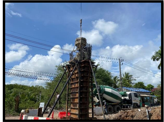
ภาพแสดงงานเทคอนกรีตเสา (P๓)
