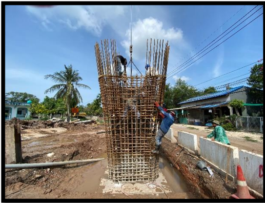
ภาพแสดงงานผูกเหล็กเสา (P๒)
