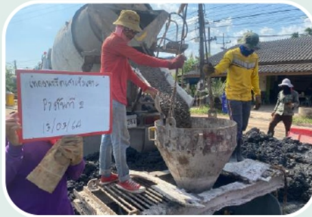
งานเสาเข็มเจาะ (P7/2) ขนาดเส้นผ่าศูนย์กลาง 1.50 ม.
