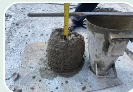
งานตรวจสอบคุณภาพคอนกรีต
