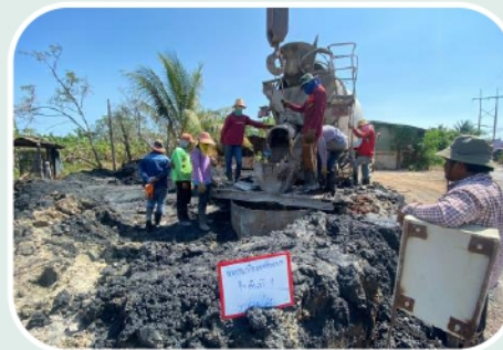
งานเสาเข็มเจาะ (P7/1) ขนาดเส้นผ่าศูนย์กลาง 1.50 ม.
