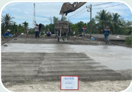
งานโครงสร้างพื้นด้านบน (Abutment)
