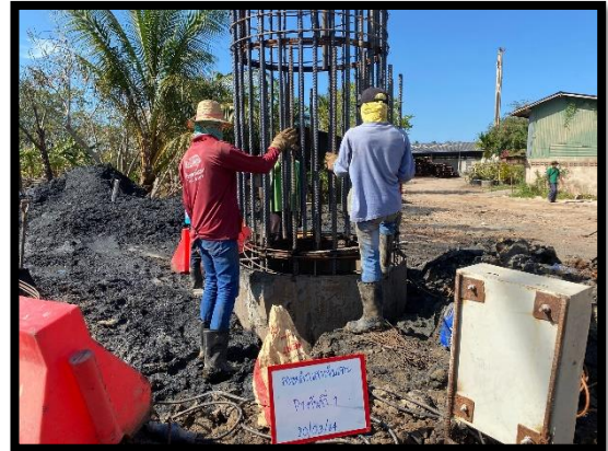
ภาพแสดงงานผูกเหล็กเสาเข็มเจาะ (P๗/๑)
