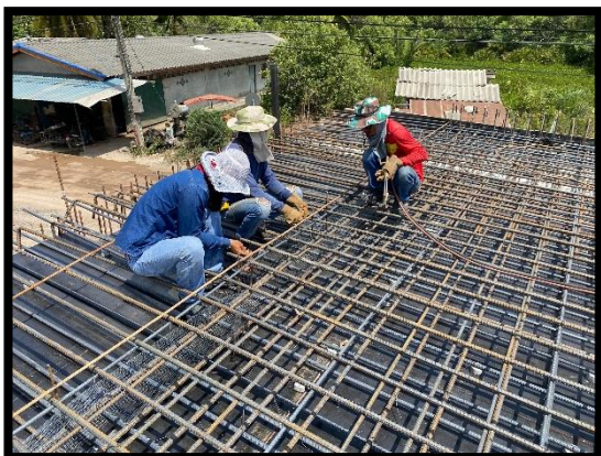
ภาพแสดงงานผูกเหล็กพื่น (Abutment)
