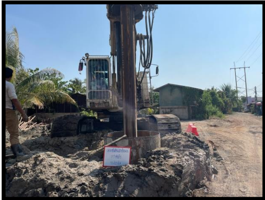
ภาพแสดงงานเสาเข็มเจาะขนาดเส้นผ่านศูนย์กลาง ๑.๕๐ ม. (P๗/๑)
