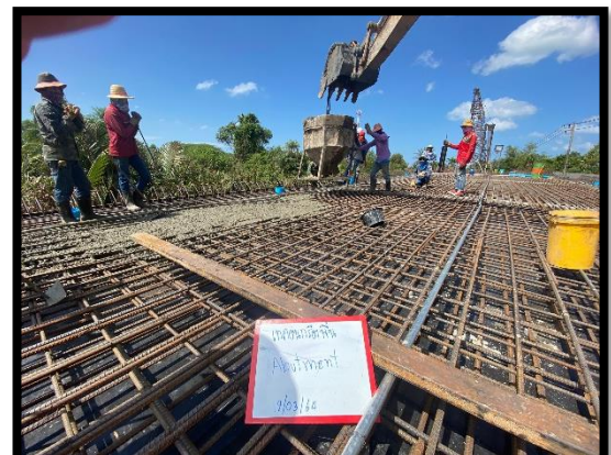
ภาพแสดงงานเทคอนกรีตพื่น (Abutment)
