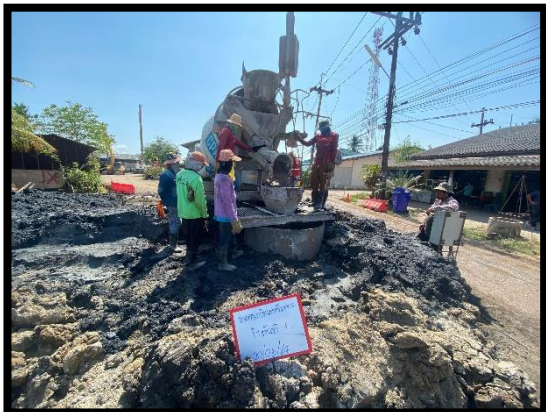
ภาพแสดงงานเสาเข็มเจาะขนาดเส้นผ่านศูนย์กลาง ๑.๕๐ ม. (P๗/๑)
