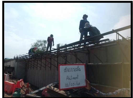
ภาพแสดงงานเข้าแบบพื่น (Abutment)
