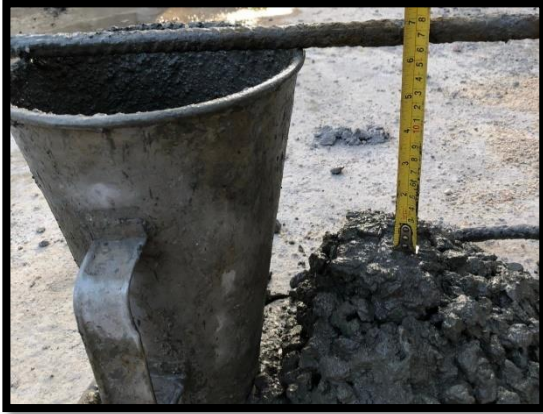
ทดสอบค่ายุบตัวของคอนกรีตงานเสาเข็มเจาะ
