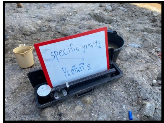
ภาพแสดงงานทดสอบสารละลายพยุงหลุมเจาะ
