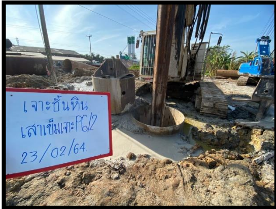
ภาพแสดงงานเสาเข็มเจาะขนาดเส้นผ่านศูนย์กลาง ๑.๕๐ ม. (P๖/๒)
