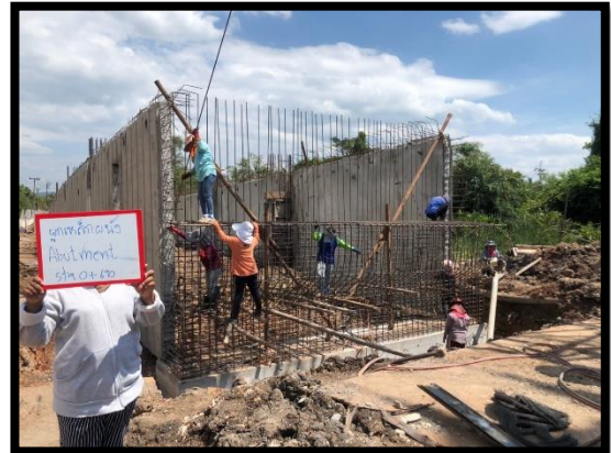
ภาพแสดงงานผูกเหล็กผนัง (Abutment)
