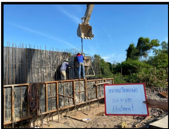
ภาพแสดงงานเทคอนกรีตตอม่อ Abutment
