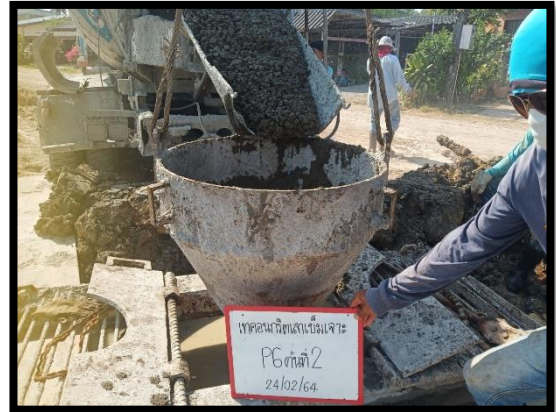
ภาพแสดงงานเทคอนกรีตเสาเข็มเจาะ (P๖/๒)
