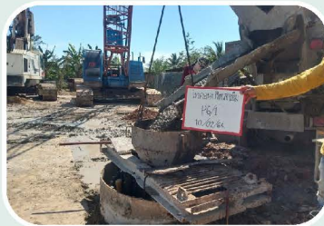
งานเสาเข็มเจาะ (P6/1) ขนาดเส้นผ่าศูนย์กลาง 1.50 ม.
