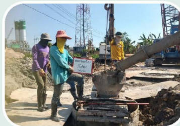
งานเสาเข็มเจาะ (P6/2) ขนาดเส้นผ่าศูนย์กลาง 1.50 ม.
