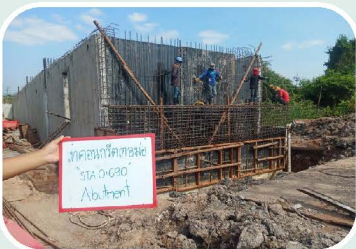
งานโครงสร้าง Abutment (P1)
