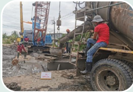
งานเสาเข็มเจาะ (P4) ขนาดเส้นผ่าศูนย์กลาง 1.50 ม.
