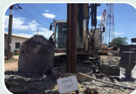
งานเสาเข็มเจาะ (P5/1) ขนาดเส้นผ่าศูนย์กลาง 1.50 ม.
