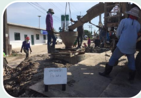
งานเสาเข็มเจาะ (P5/2) ขนาดเส้นผ่าศูนย์กลาง 1.50 ม.
