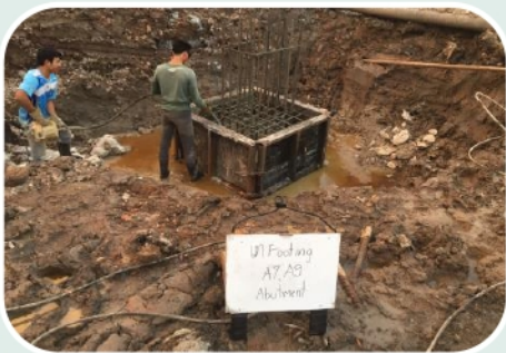
งานโครงสร้างฐานราก Abutment
