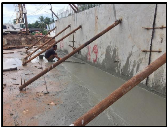
ภาพแสดงการติดตั้งชิ้นส่วนผนังกำแพงกันดิน (Transition)
