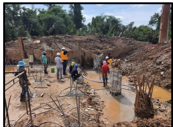
ภาพแสดงงานทดสอบความสมบูรณ์ของเสาเข็มเจาะ ด้วยวิธี Seismic
