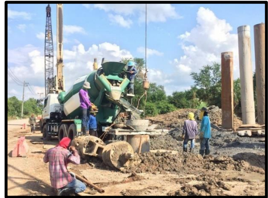
ภาพแสดงงานเสาเข็มเจาะขนาดเส้นผ่านศูนย์กลาง ๐.๘๐ ม. (Abutment)
