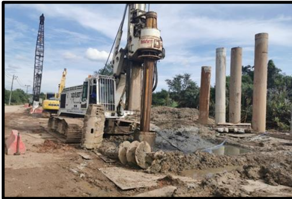
ภาพแสดงงานเสาเข็มเจาะขนาดเส้นผ่านศูนย์กลาง ๐.๘๐ ม. (Abutment)
