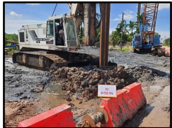
ภาพแสดงงานเสาเข็มเจาะขนาดเส้นผ่านศูนย์กลาง ๑.๕๐ ม. (P๒)
