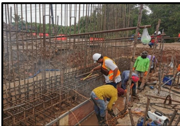
ภาพแสดงงานโครงสร้าง (Abutment)
