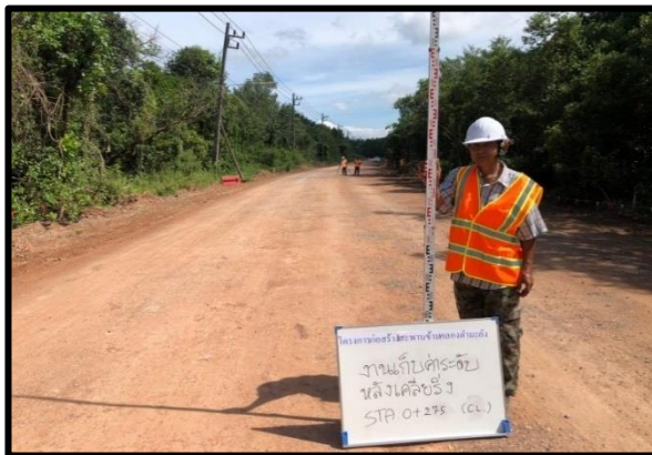
ภาพแสดงงานเก็บค่าระดับหลังปรับเกลี่ยแต่งคันทาง เดิม
