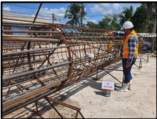
ภาพแสดงงานเสาเข็มเจาะขนาดเส้นผ่านศูนย์กลาง ๑.๕๐ ม. (P๓)
