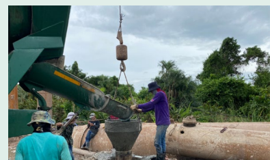
งานเสาะเข็มเจาะขนาดเส้นผ่านศูนย์กลาง 0.80 ม. (Abutment)
