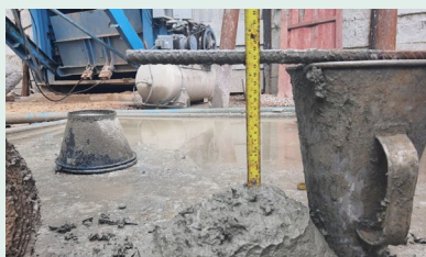
งานตรวจสอบคุณสมบัติวัสดุ คอนกรีต (Abutment)
