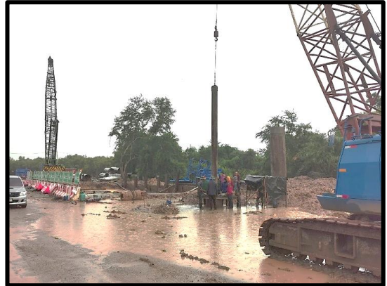
งานเสาเข็มเจาะขนาดเส้นผ่านศูนย์กลาง ๐.๘๐ ม. (Abutment) A ๑๓
