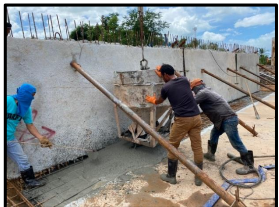
การติดตั้งชิ้นส่วนผนังกำแพงกันดิน (Transition)
