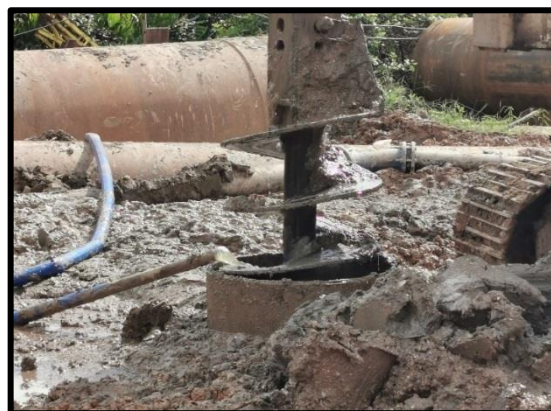
งานเสาค้ำเข็มเจาะขนาดเส้นผ่านศูนย์กลาง ๐.๘๐ ม. (Abutment) A๒
