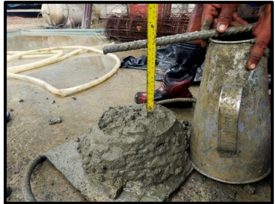
การตรวจสอบเหล็กเส้นเสริม,ทดสอบค่ายุบตัวของ คอนกรีตงานเสาค้ำเข็มเจาะ A๒
