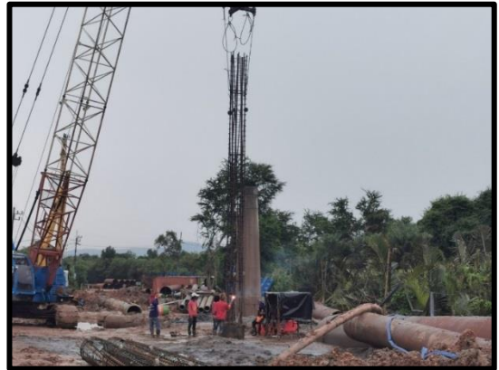
งานปัก casing เสาค้ำเข็มเจาะ ขนาด ๐.๘๐ m. Abutment ต้นที่ A ๑๕
