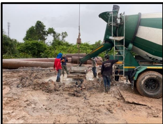
งานเสาค้ำเข็มเจาะขนาดเส้นผ่านศูนย์กลาง ๐.๘๐ ม. (Abutment) A๑
