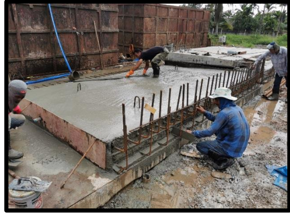
งานคอนกรีตผนังกำแพงกันดิน Transition
