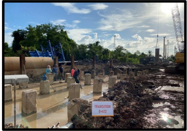
งานคอนกรีตหยาบ (ทรายหยาบรองพื้น) Transition
