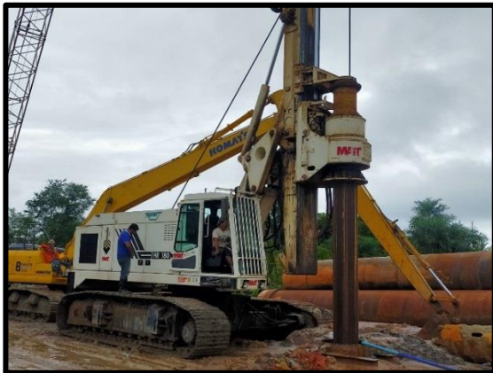
ภาพแสดงงานปักเสาเข็มเจาะ ขนาด 0.80 m. Abutment ต้นที่ A/1
