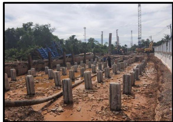
งานตัดเสาเข็มตอกขนาด ๐.๔๐x๐.๔๐ ม. (Transition)
