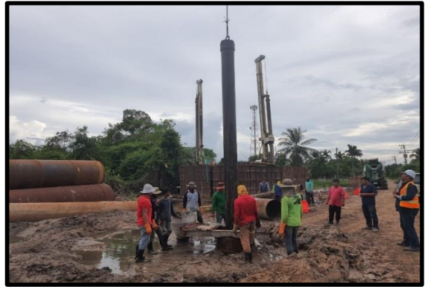
งานเสาเข็มเจาะขนาดเส้นผ่านศูนย์กลาง ๐.๘๐ ม. (Abutment) A๑
