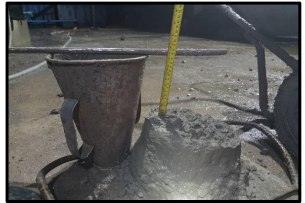
การตรวจสอบเหล็กเส้นเสริม,ทดสอบค่ายุบตัวของ คอนกรีตงานเสาเข็มเจาะ A๑
