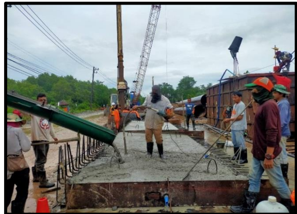
งานเทคอนกรีตผนังกำแพง Transition
