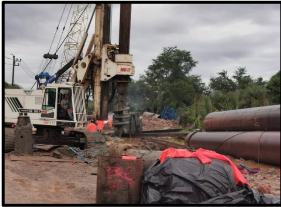
งานเสาเข็มเจาะขนาดเส้นผ่านศูนย์กลาง ๐.๘๐ ม. (Abutment) A๑
