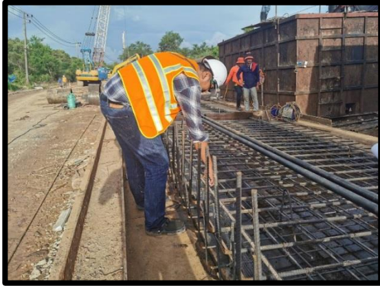
การตรวจสอบเหล็กโครงสร้างผนัง Transition
