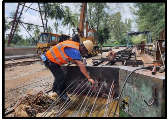
งานตรวจสอบเสาเข็มขนาด ๐.๔๐ x ๐.๔๐ m.
