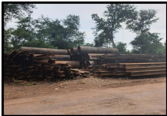
อุปกรณ์ก่อสร้าง
