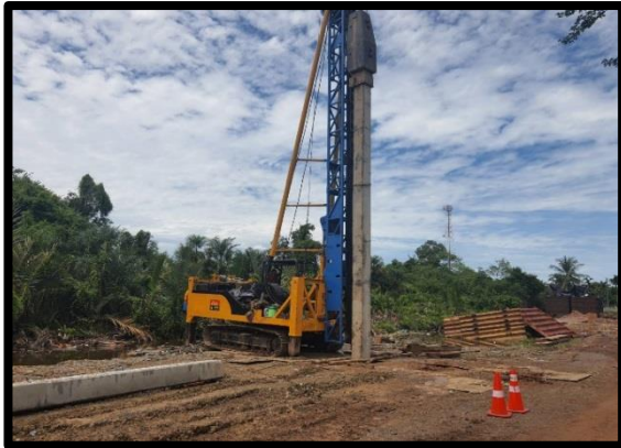
งานเสาเข็มพร้อมตอกขนาด 0.40 x 0.40 m. (Transition)
