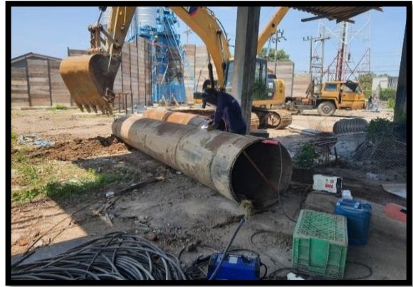
งานประกอบท่อ Casing
