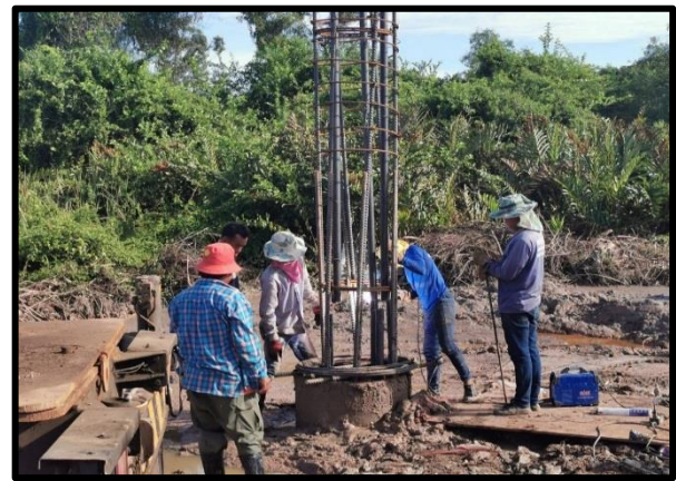
ภาพแสดงงานเสาเข็มเจาะ P๑ (Sta.๐+๖๙๐.๔๙๔)
