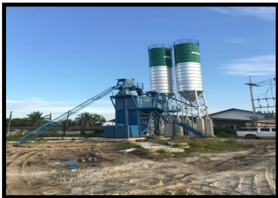
งานติดตั้งเครื่องผสมคอนกรีต
