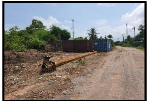
งานเตรียมอุปกรณ์สำหรับงานเข็มเจาะ
