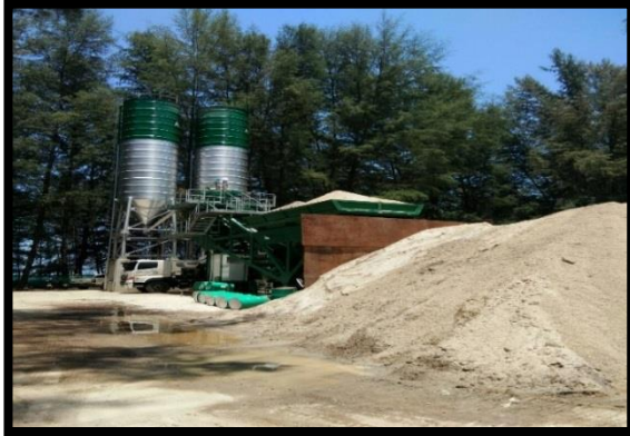
งานตรวจสอบโรงผลิตเสาเข็มคอนกรีตอัดแรง
