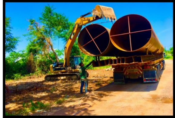
ภาพท่อแคนซึ่งสำหรับงานเข็มเจาะ
