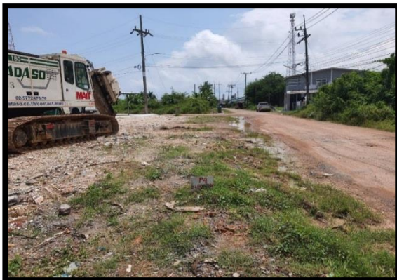
งานปรับพื้นที่สำหรับเสาเข็มเจาะ P-2 ถึง P-8
