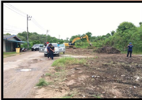
งานปรับพื้นที่แนวเขตก่อสร้าง
