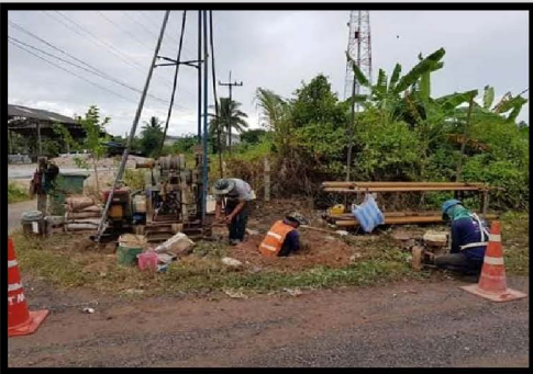
งานเจาะสำรวจสภาพชั้นดิน
